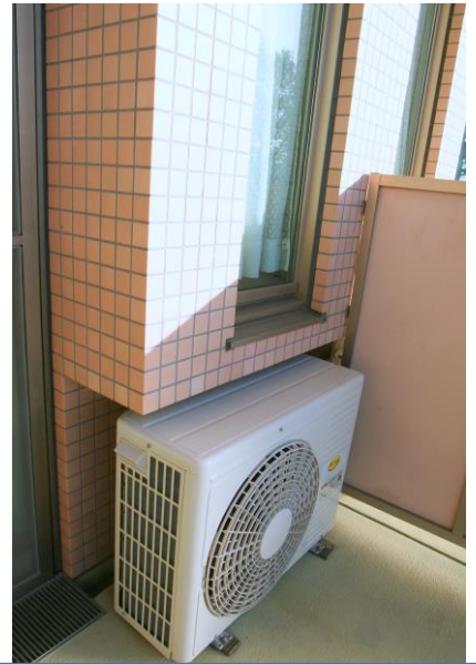
ベランダにエアコン室外機
