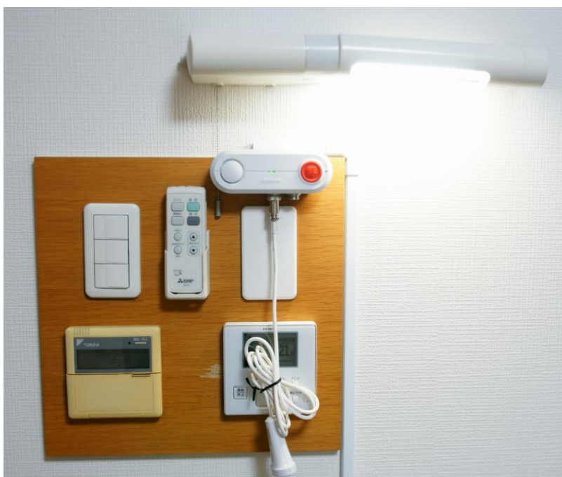
ベッドサイドに、ナースコール、エアコン（冷暖房ドライ）、全熱交換機能換気扇、ライトのスイッチ有り
